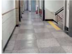
大義館二樓走廊 磨石子鋪貼
